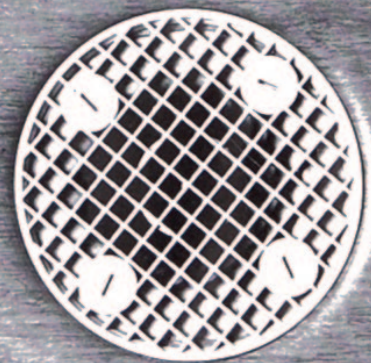
Tarkett golvbrunn grön med helt galler i golv med plastmatta.
