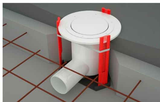
Figur 11. Fixering av golvbrunn med hjälp av fixtur inför betonggjutning.
