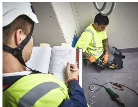
Kontroll och dokumentation GVK tillhandahåller hjälpmedel för att kvalitetssäkra våtrumsinstallationer.
